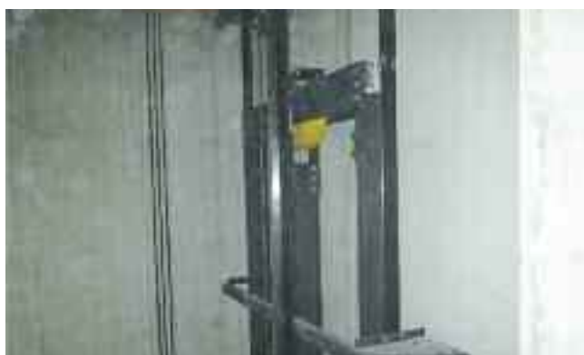
Stahlkonstruktion für den Aufzug.
