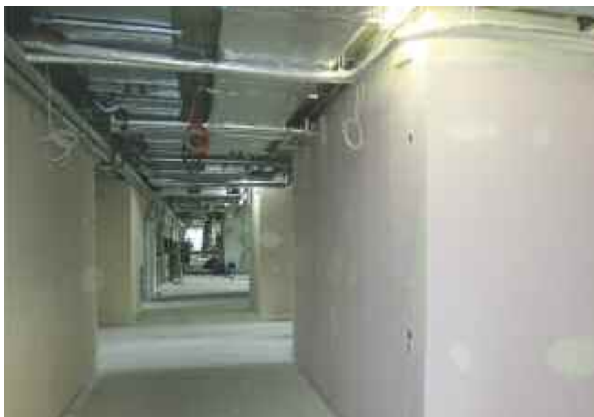
Letzte Arbeiten, bevor auch hier die Decken geschlossen werden.
