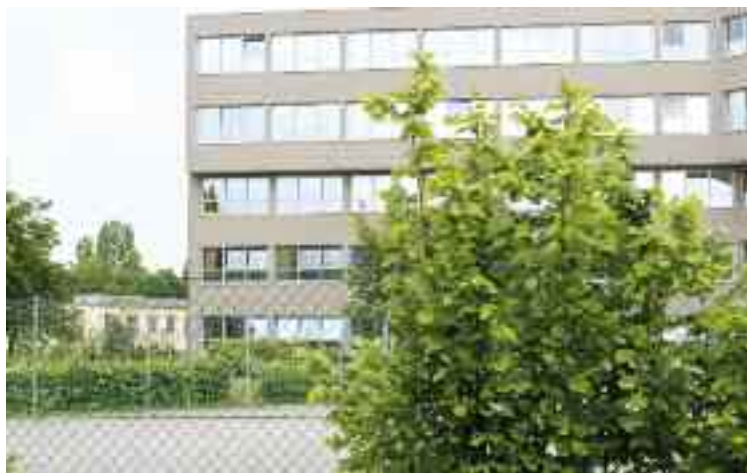
An dieser Stelle soll das Haus C erweitert werden.
